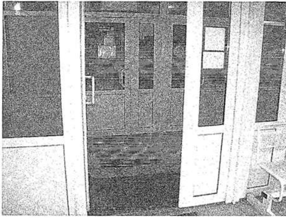
Тамбур на входе № 6
