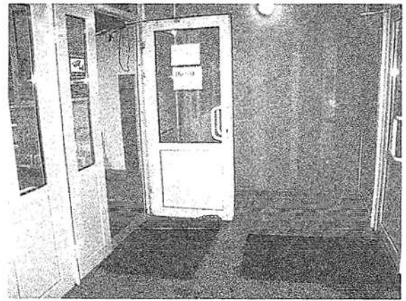
Тамбур на входе № 7
